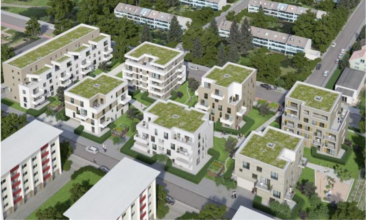
Ein Riegelgebäude und sechs Punkthäuser: Das Neubauprojekt der GBG in der Neckarstadt soll bis Anfang 2020 fertig sein.
